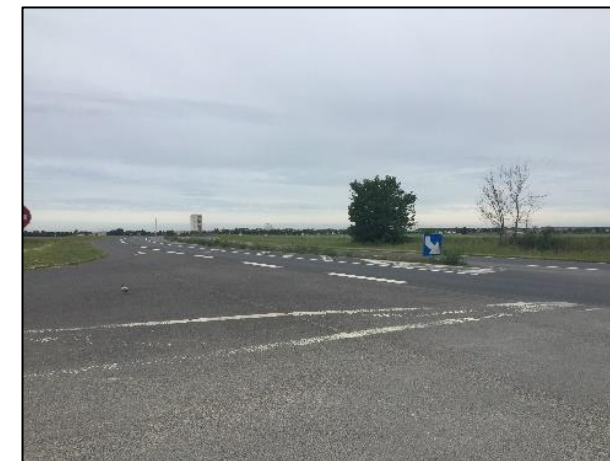
Route D1330 à proximité du site d'étude Source : ARTIFEX 2020
